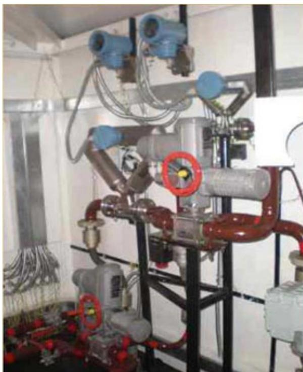
На случай пролива предусматривается уклон и централизованный сбор жидкости. Для обеспечения взрывобезопасности применяются взрывозащищенные приборы и устройства, устанавливается система пожарной сигнализации, обеспечивается требуемая вентиляция, осуществляется контроль загазованности.
